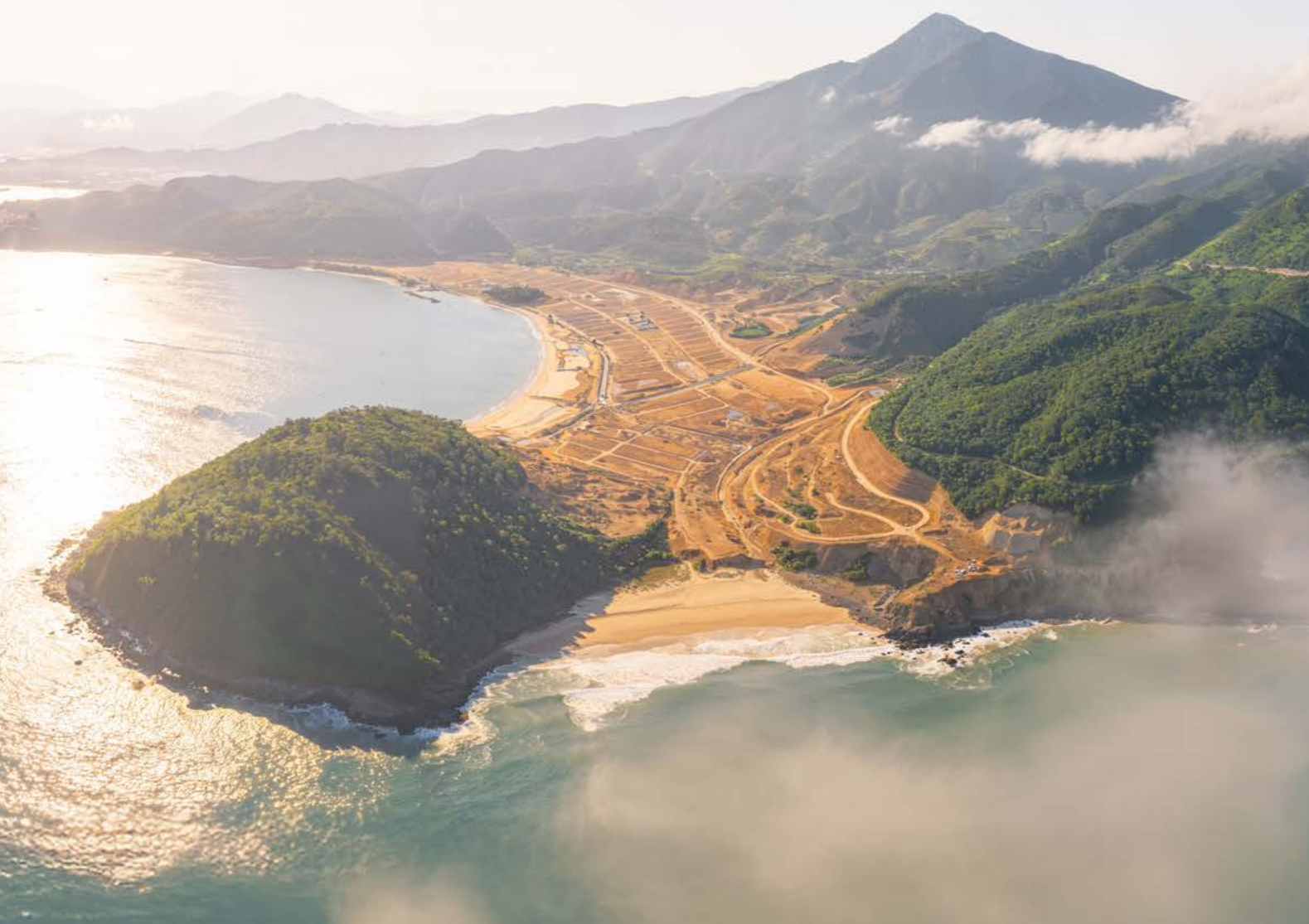
Lang Van construction site
